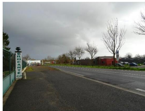
2/ Alignement sur la RD 960 bis, à l'arrivée sud-ouest sur @lphaparc
